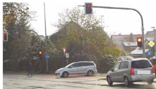
Die Vorampel bewährt sich. Vom Heßdorfer Weg (rechts) kann jetzt unbehindert auf die Weisendorfer Straße gefahren werden
